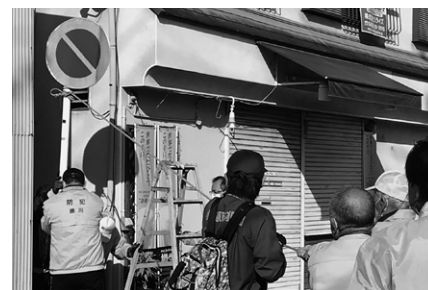
交通標識修繕（豊川）
