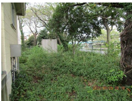
防災倉庫への動線が雑草に覆われていた。
