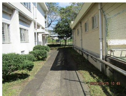
防災倉庫への通路が綺麗になりました。
