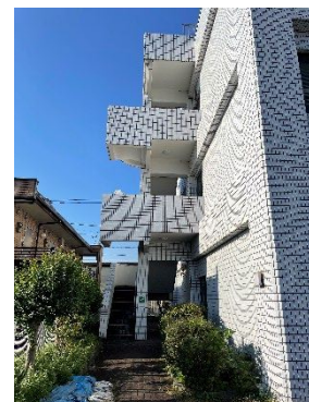
外階段で屋上へ上りました。
