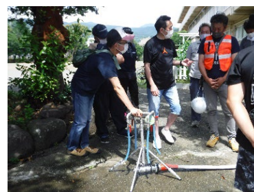
蛇口を取付けます。
