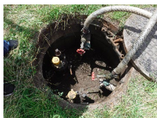
耐震性貯水槽からポンプアップして給水します。100 m 3 の飲料水が確保できます。
