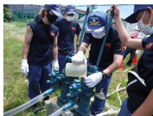
耐震性貯水槽からポンプアップして給水します。100 m 3 の飲料水が確保できます。
